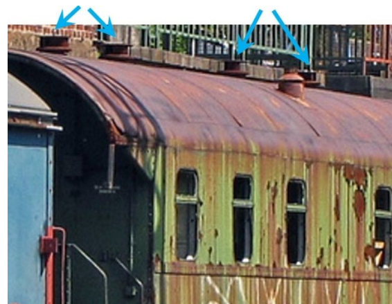
Abb. 6: Savonius-Lüfter auf einem alten Eisenbahn-Waggon
