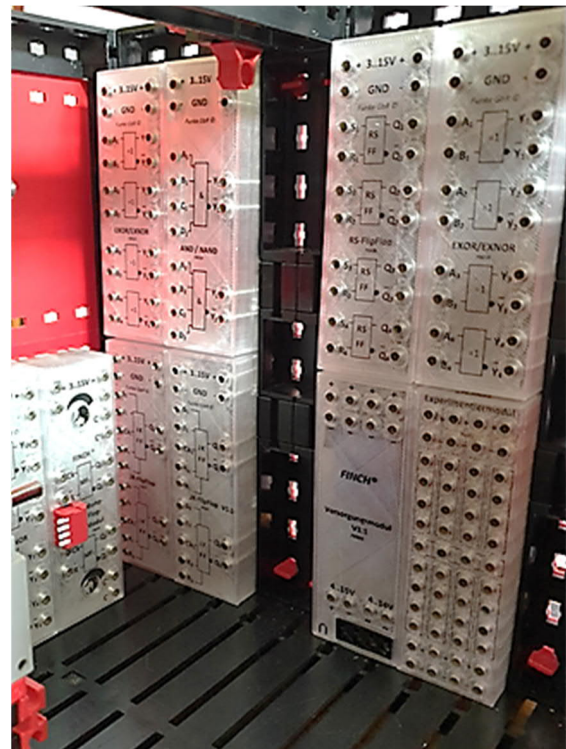
Abb. 19: Von unten nach oben eingesetzt
