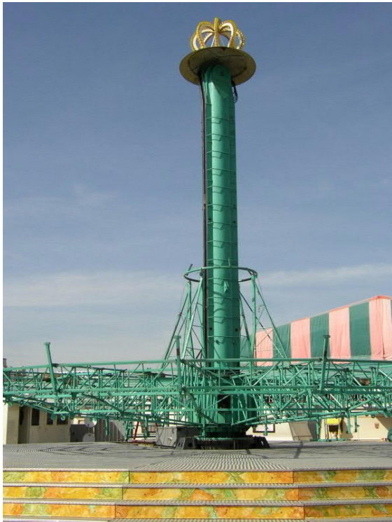
Abb. 3: Der Aufbau ist fast fertig (Bild: Harald Steinhaus)
